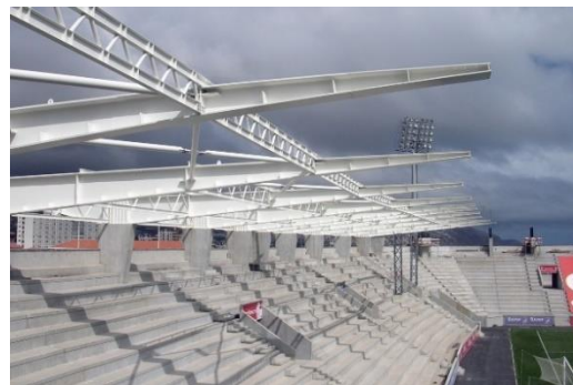
Figura 2.2: Estrutura de cobertura metálica em viga de alma cheia de altura variável – Estádio do C.S. Marítimo (Projeto GRID)
