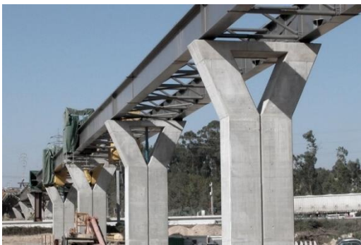
Figura 2.1: Vigas de alma cheia em pontes mistas aço-betão – Viaduto Parque da Maia (Projeto GRID)
